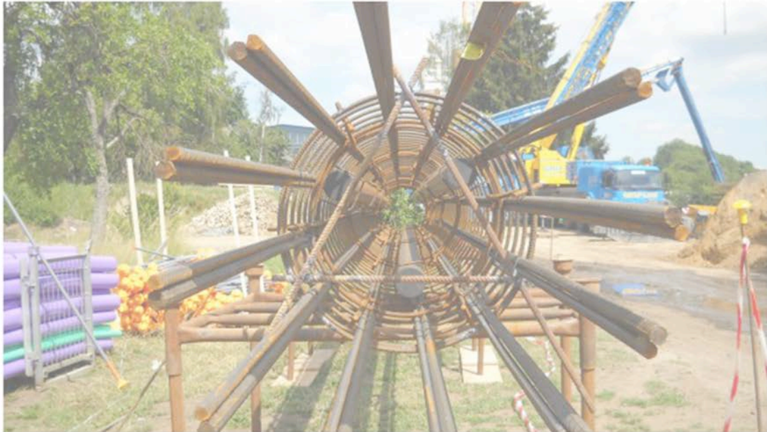
Recépieux sur le chantier du viaduc ferroviaire de Pulvermühle au Luxembourg
